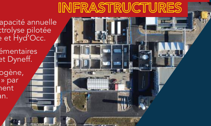
Hyd'Occ à Port-la-Nouvelle, 20 MW de production d'hydrogène par électrolyse
