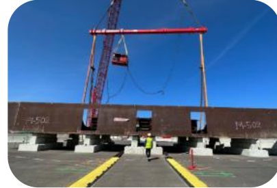
Blocs constitutifs des flotteurs
