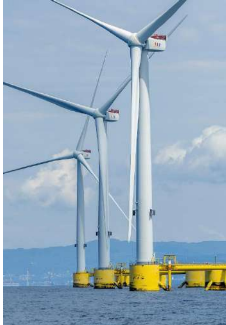
25 MW WindFloat Atlantic (2020)
