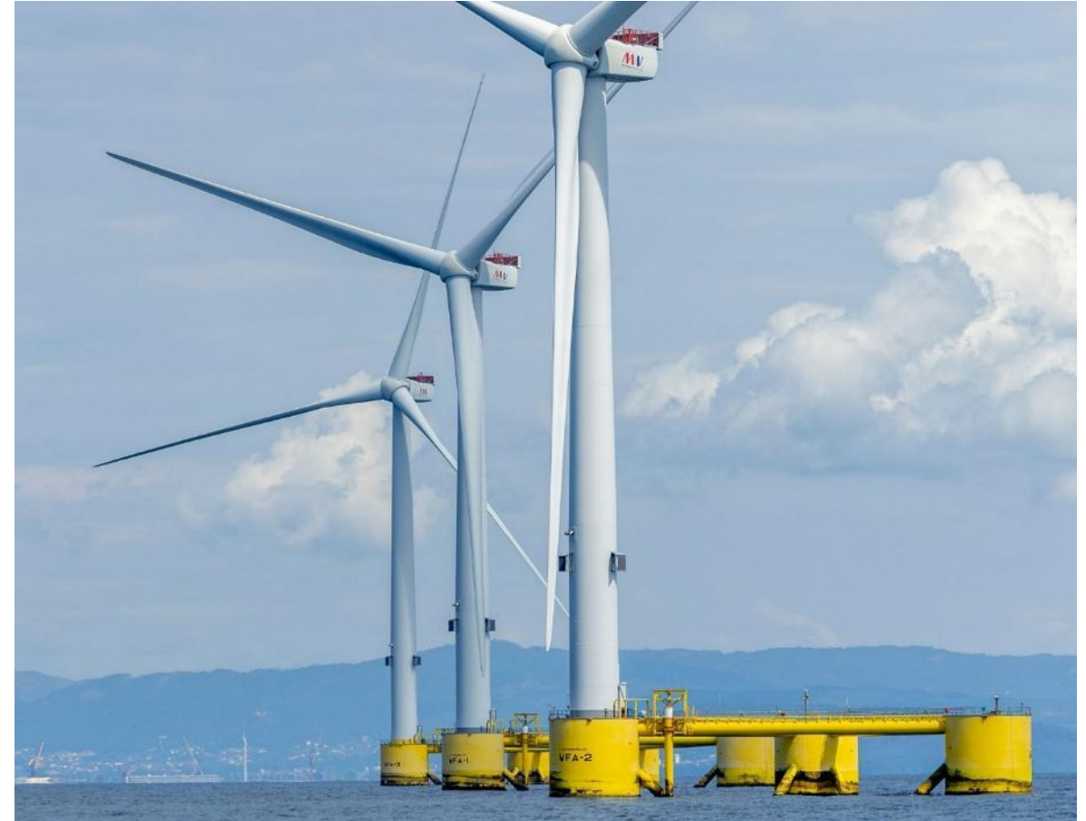
Projet WindFloat Atlantique 25 MW (Image: Ocean Winds)
